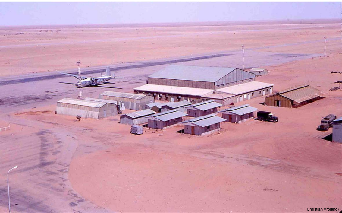
Début de l'installation, avec un Hurel-Dubois HD 34 de l'IGN sur le parking
